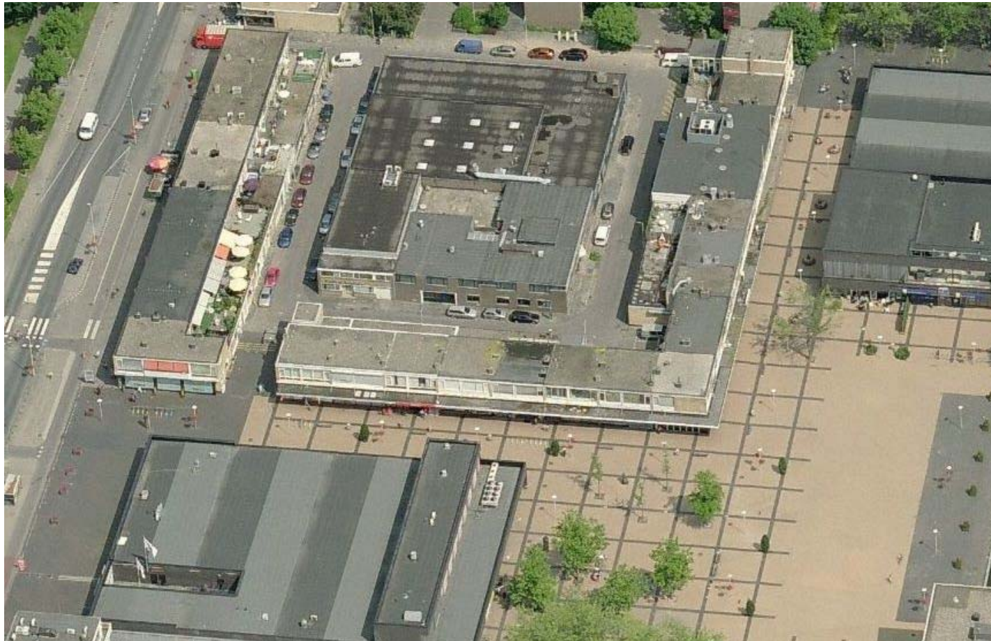
Woningen Baarlandhof Woningen Plein 1953
