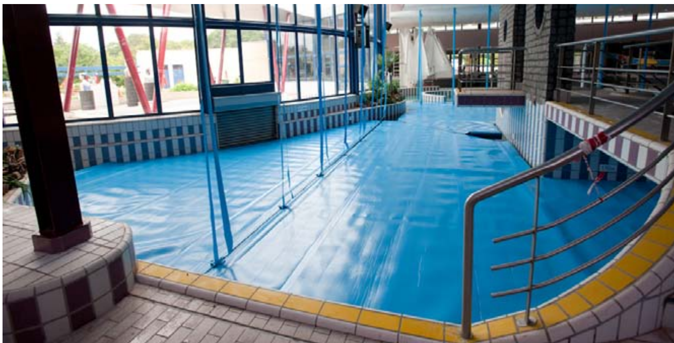
Doeken op het water voorkomen warmteverlies en beperken verdamping, wat de benodigde energie voor ventilatie verlaagt.
