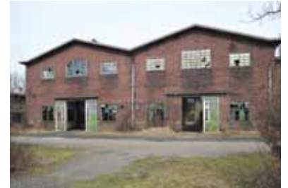
Nieuw Hembrug in Zaanstad. Grote industriële site die wacht op herontwikkeling. / Foto: Rijksvastgoed- en ontwikkelingsbedrijf.
