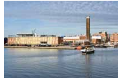
De Caballerofabriek in Den Haag, nu een cultureel verzamelgebouw en blikvanger van het bedrijventerrein de Binckhorst. / Foto: Hollandse Hoogte, Inge van Mill.
